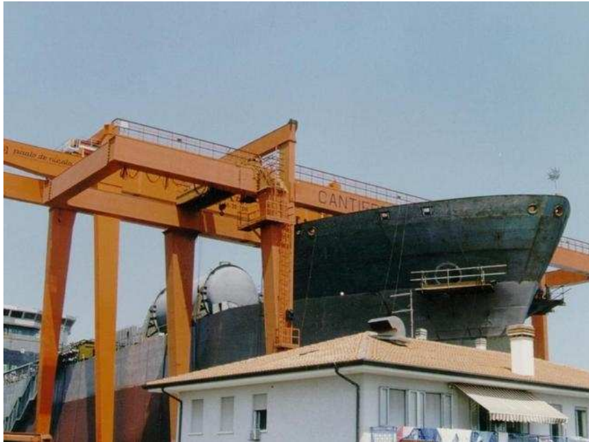
Chimichiera in costruzione Cantieri De poli primi anni 2000
