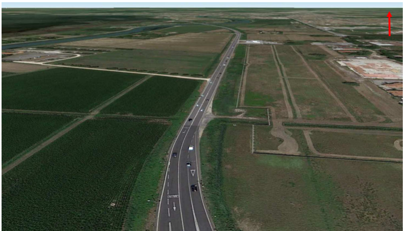
S.R. n. 43 (Via Adriatico) a nord di rotonda Picchi, vista prospettica (da Google Earth)
