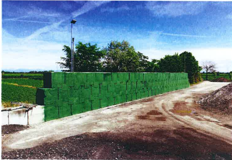
Foto 1 – Lato Nord con barriera fonoassorbente esistente e angolo Nord-Est dove verrà posizionata la nuova barriera fonoassorbente
