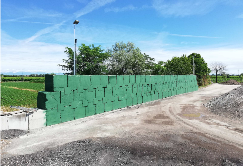
Foto 1 – Lato Nord con barriera fonoassorbente esistente e angolo Nord-Est dove verrà posizionata la nuova barriera fonoassorbente
