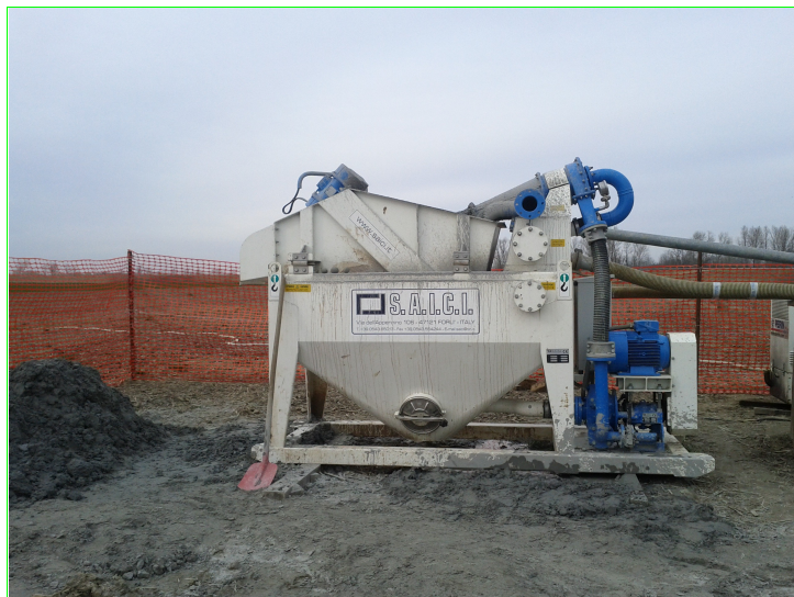
Figura 1 – Esempio di vibrovaglio utilizzato in cantiere.
