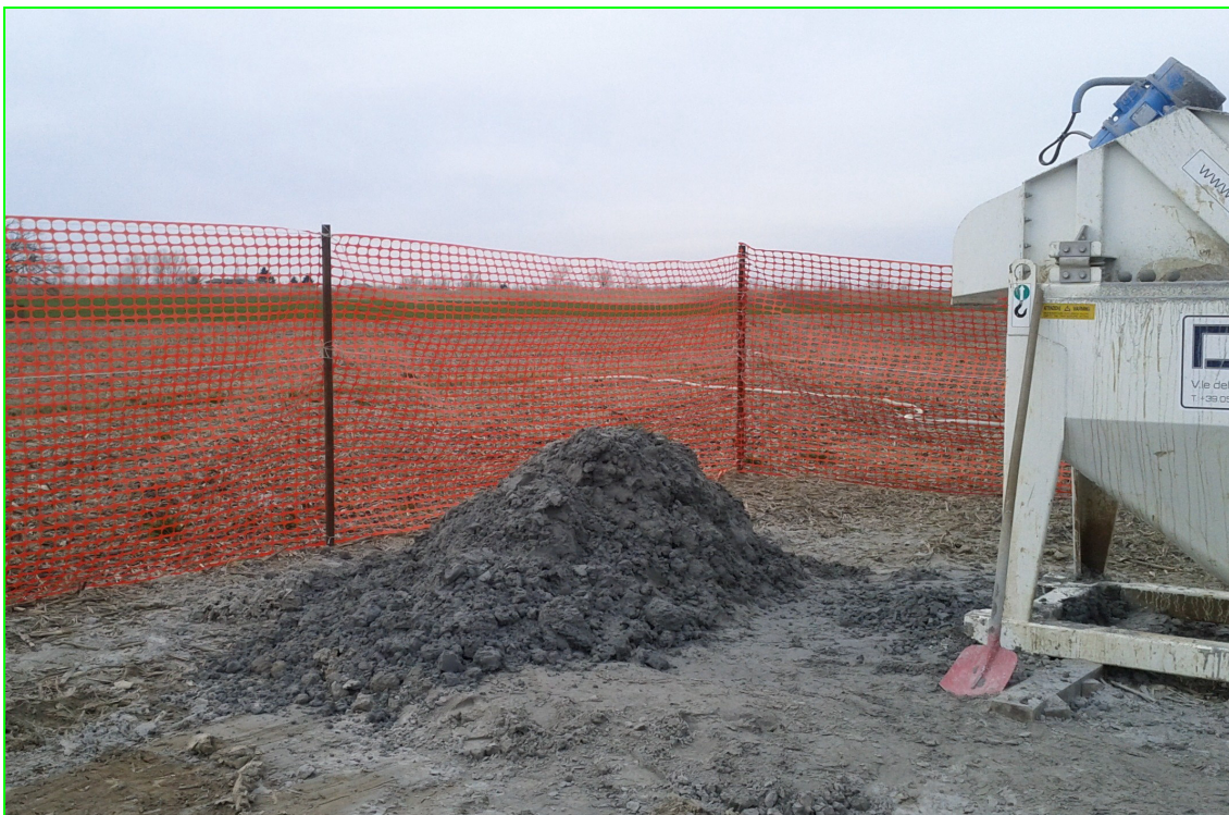
Figura 4 – Esempio di materiale sabbioso in uscita dal vibrovaglio.
