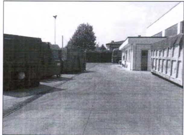
Fig. 2 - area deposito cassoni vuoti
