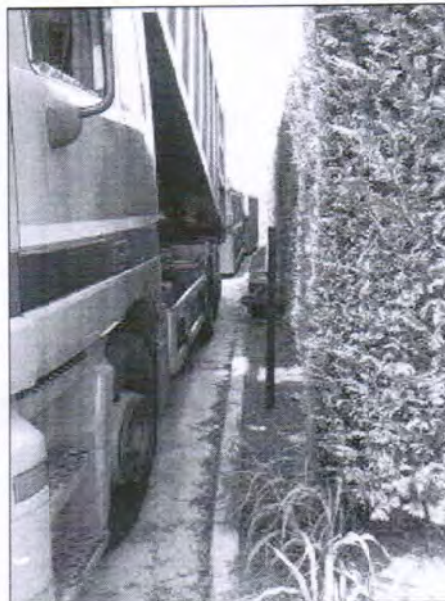
Fig. 18: Cordolo perimetrale di protezione delle aree verdi adiacenti al piazzale
