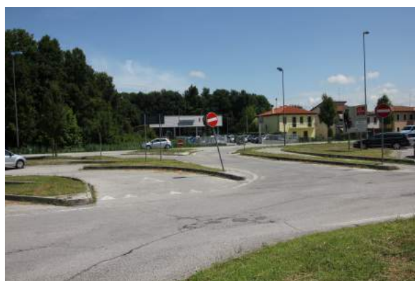
Figura 14 – Vista ingresso nord da via Cavin di Sala
