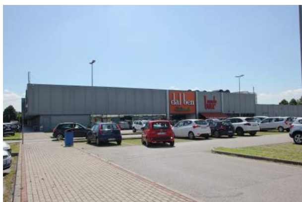
Figura 13 – Vista facciata ovest e parcheggio
