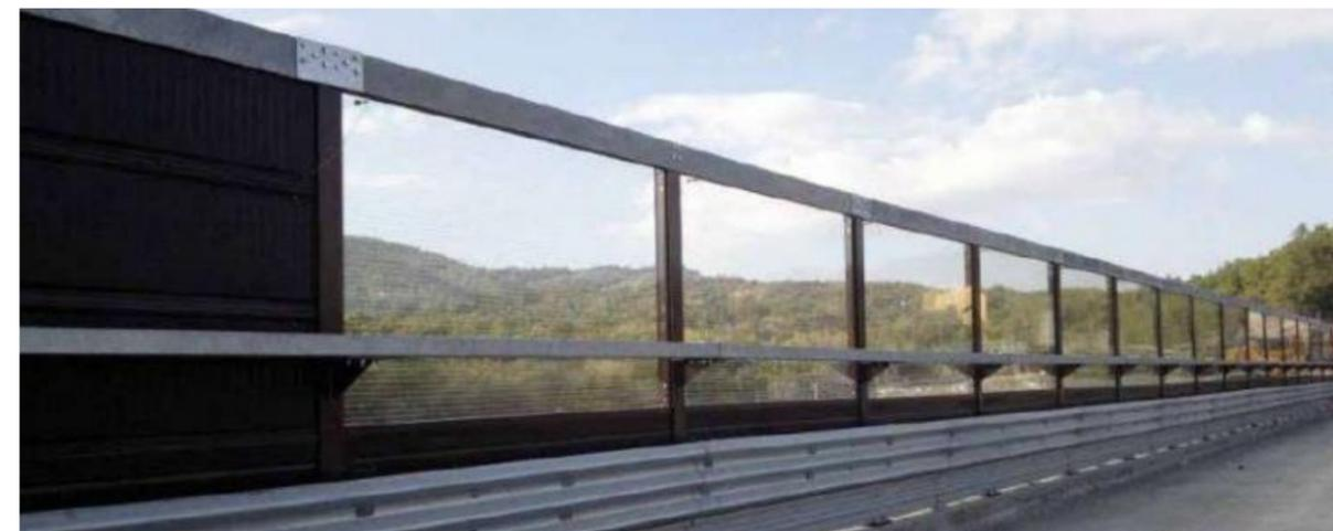
Figura 189 - Tipologico barriera integrata parzialmente trasparente.
